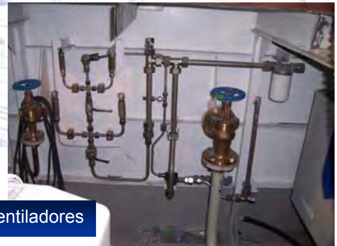
Tubería Alta Presión Inox. Sistema BOP.
